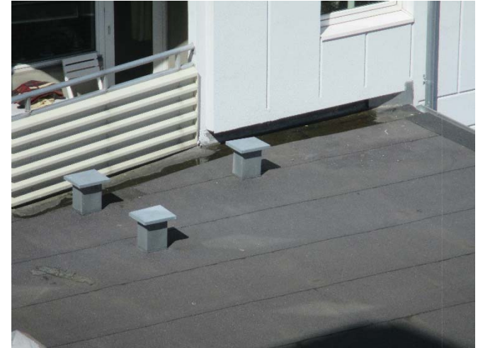
Tag på servicebygning med lunkedannelser ind mod Blok B
