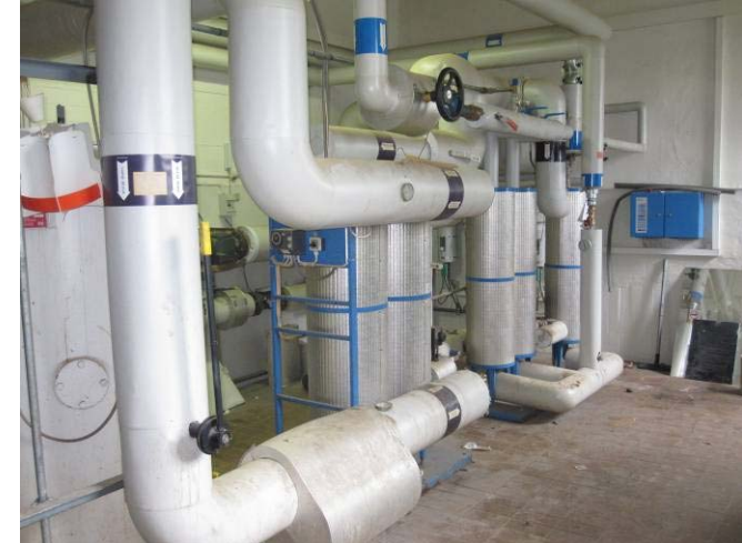
Varmecentral – veksler for centralvarme og brugsvand.
