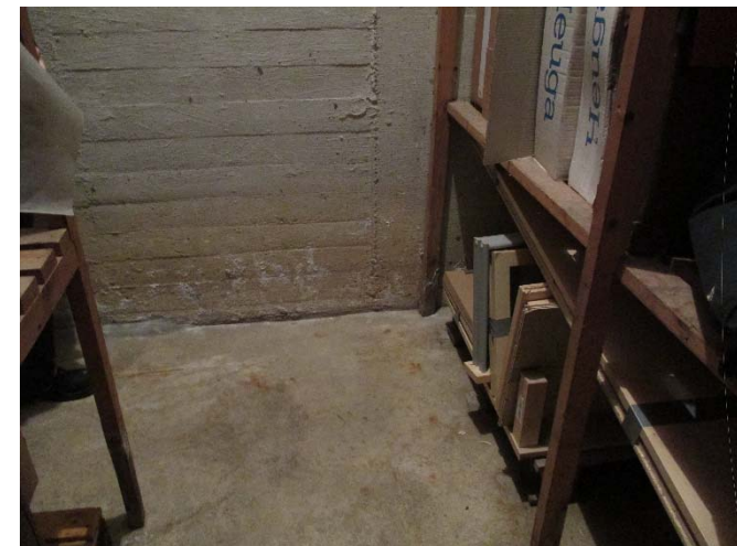
Grundvandsfugt i pulterrum blok A
