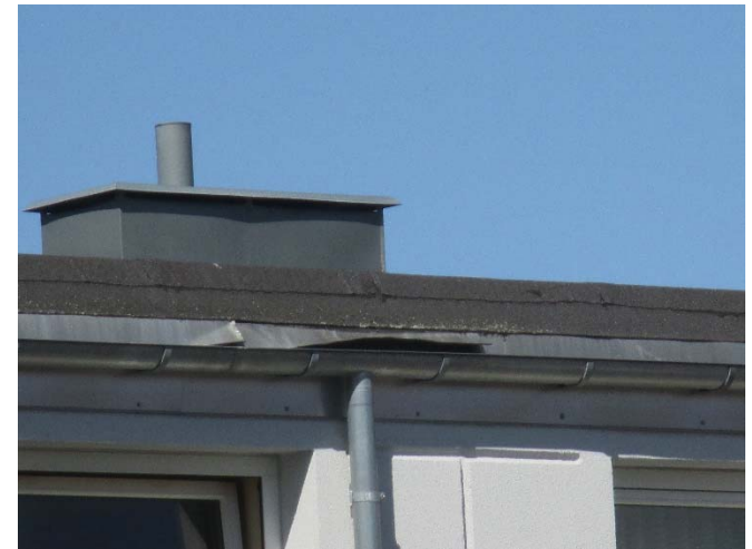
Tagfod på blok B mod servicebygning skal oprettes.
