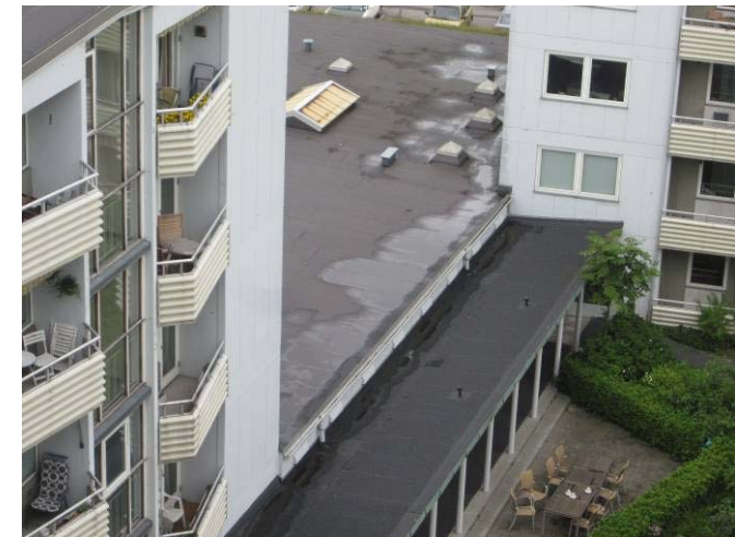
Tag på servicebygning med lunkedannelser
