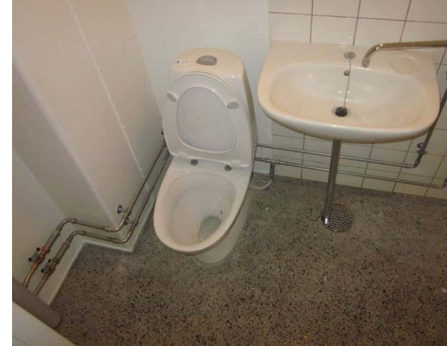
Nyere vandinstallation i badeværelse i lejlighed
